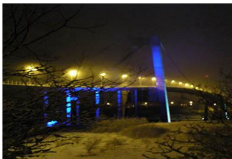
Belysning av Nærøysund bru.
