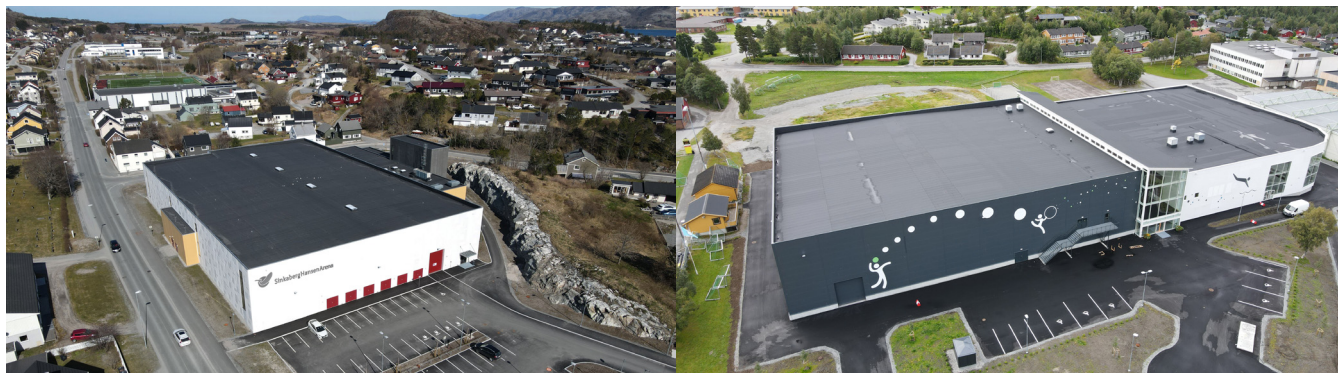
Flerbrukshallene SinkabergHansen arena og Nærøysund arena ble ferdigstilt i 2021
