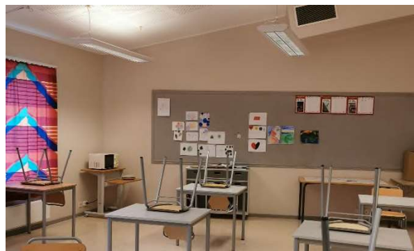
Figur 71: Klasserom i byggetrinn 2, bra tilstand
