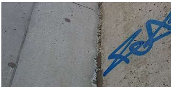
Figur 55: Riss og avskalling betong amfi/støttemur
