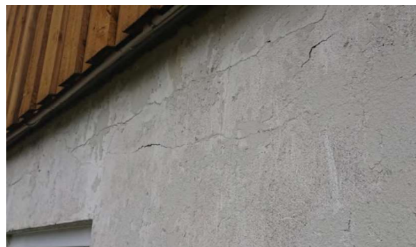
Figur 12: Omfattende betongskader/armeringskorrosjon
