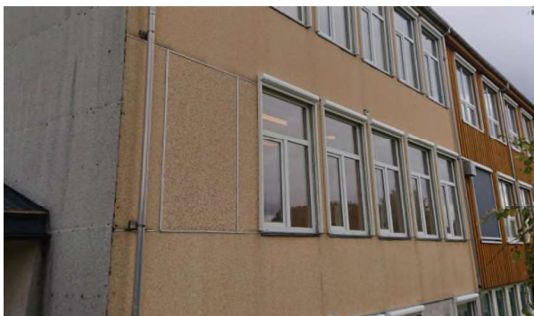
Figur 11: Fasader renovert, unntatt vestre del
