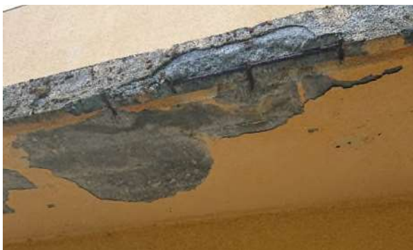
Figur 68: Hovedbygg, betongskader baldakin
