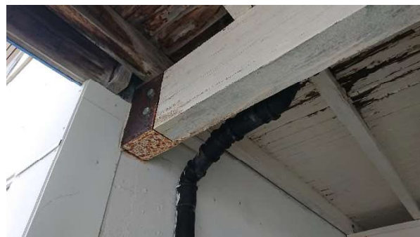
Figur 5: Råteskader mellombygg
