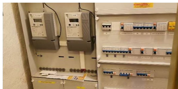
Figur 16: Oppgraderte el-tavler
