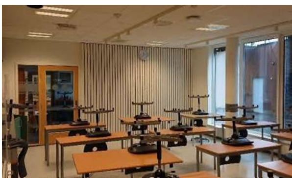
Figur 88: Rørvik skole generelt bra tilstand
