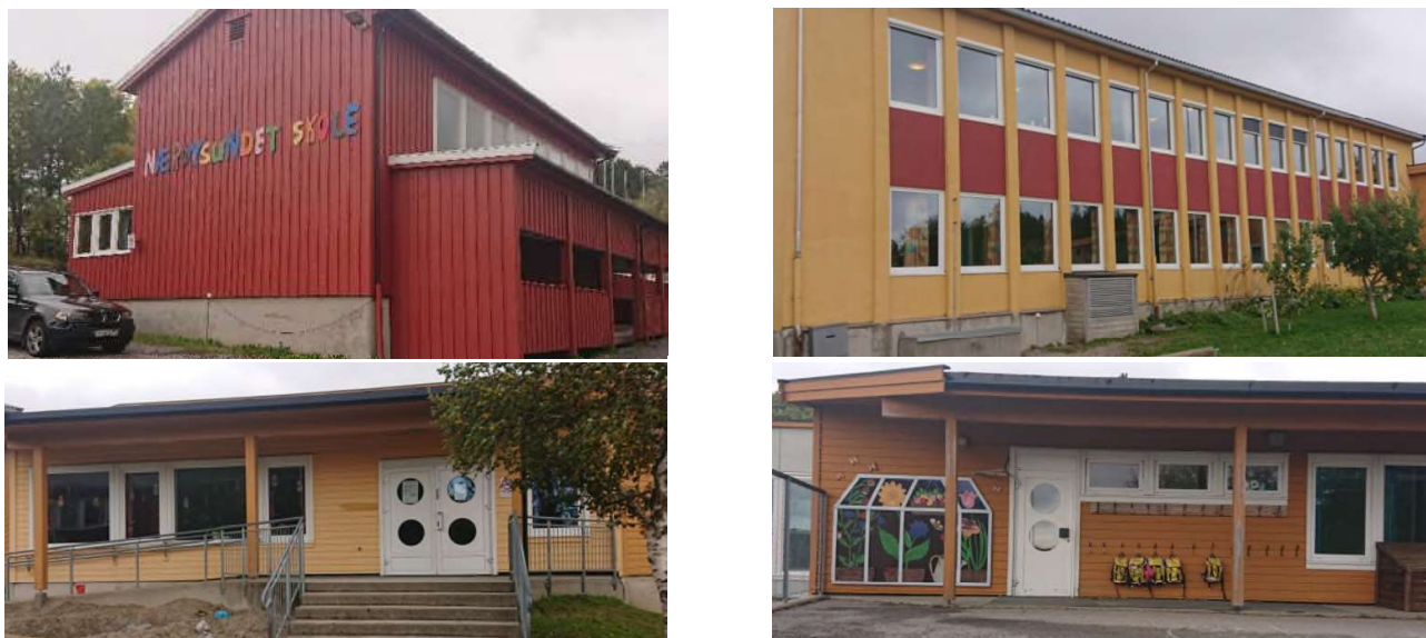
Figur 58: Byggetrinn 1 (de to øverste bildene), påfølgende henholdsvis byggetrinn 2 og 3.
