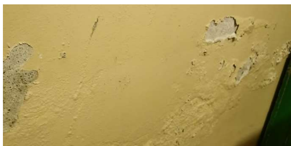
Figur 15: Fuktskader mur
