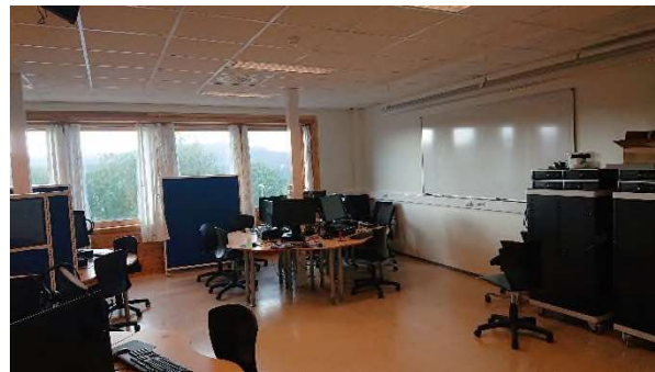
Figur 52: Innvendig bra tilstand klasserom
