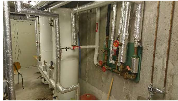
Figur 53: Bra tilstand tekniske installasjoner
