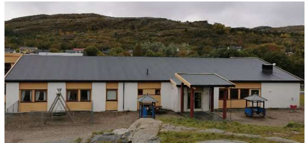
Figur 74: F.v. Over t.v: byggetrinn 1; over byggetrinn 3; under: byggetrinn 2
