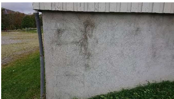
Figur 20: Sprekker/krakelering grunnmur
