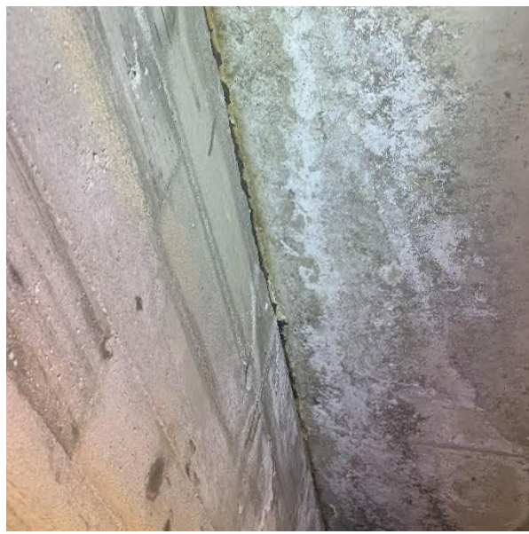
Figur 11: Fuktmerker/ avleiring i dekke
