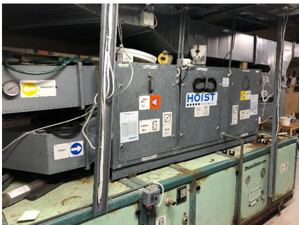
Figur 10: Bassengaggregat med gammelt aggregat som fundament- Begge rives
