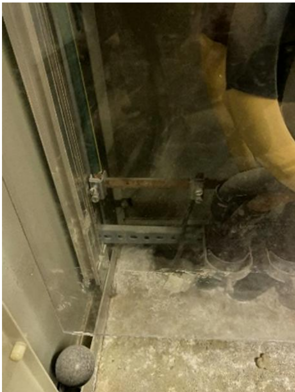
Figur 15: Tilkobling jordelektrode
