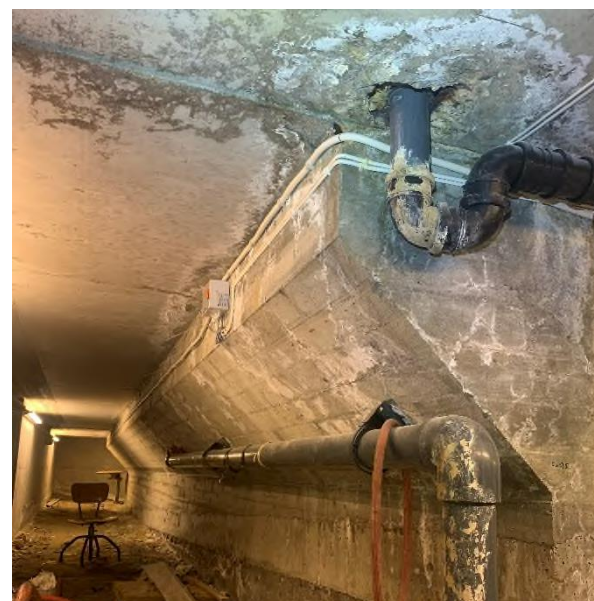
Figur 7: Fuktmerker/avleiring i bassengvegger og dekke
