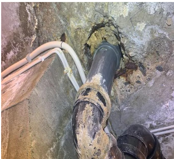
Figur 8: Armeringskorrosjon ved gjennomføring i dekke
