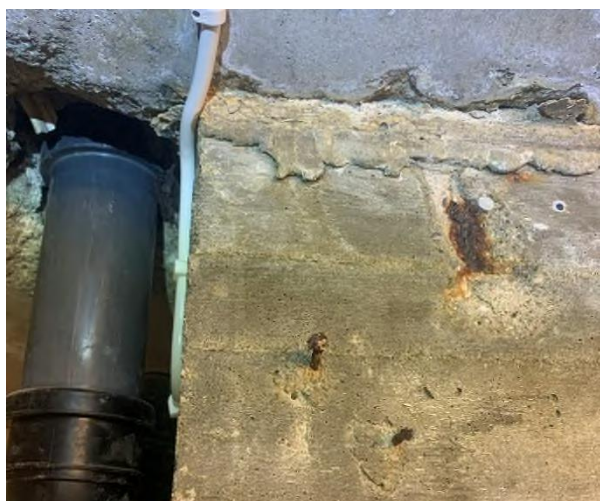
Figur 3: Rustsprengning opp mot dekke hjørne nord-øst
