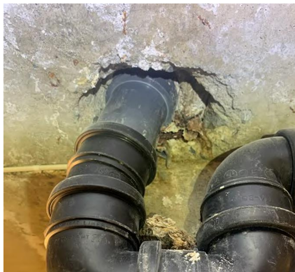
Figur 9: Armeringskorrosjon ved gjennomføring i dekke
