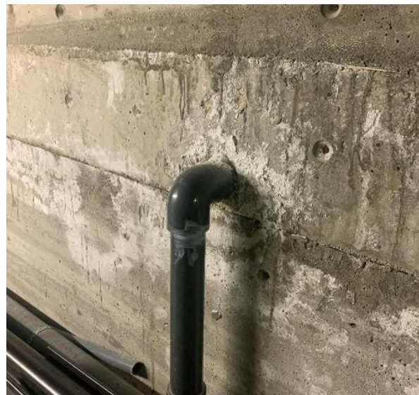
Figur 5: Fuktmerker/ avleiring ved gjennomføring
