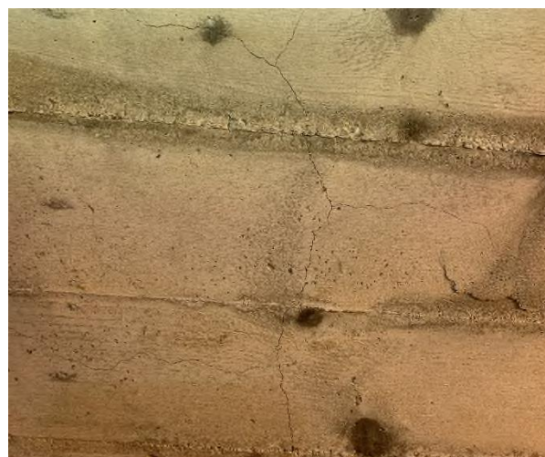
Figur 4: Riss i konstruksjon og begynnelse rustsprengning på blant annet sørsiden dyp del
