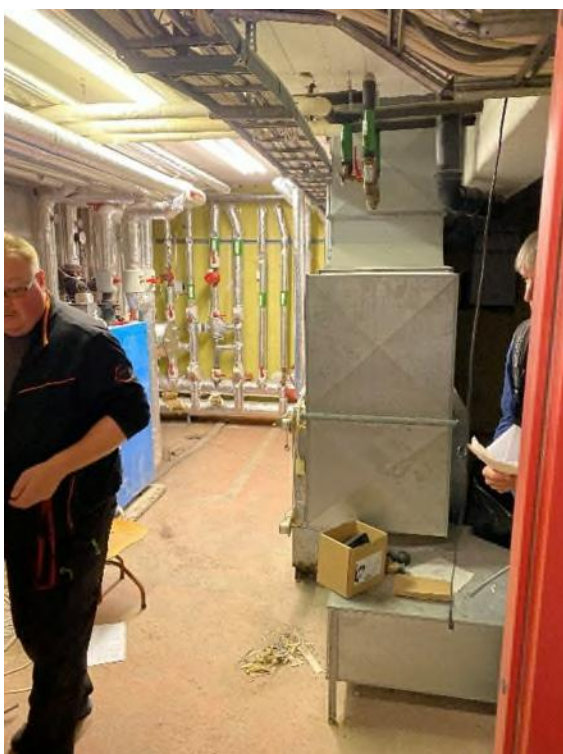
Figur 13: Kabelbruføringer
