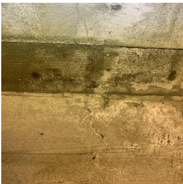
Figur 6: Fuktmerker/avleiring ved riss i bassengvegg
