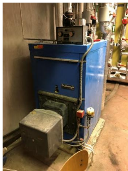
Figur 9: Oljekjel som evt kan ombygges til bioolje
