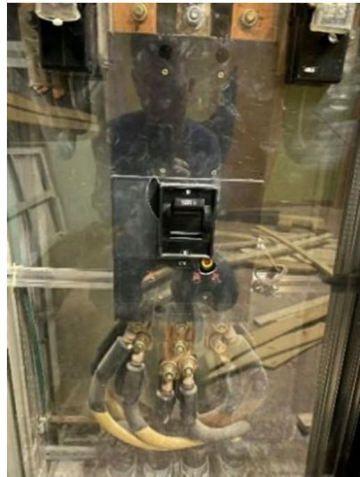
Figur 18: Effektbryter hovedfordeling
