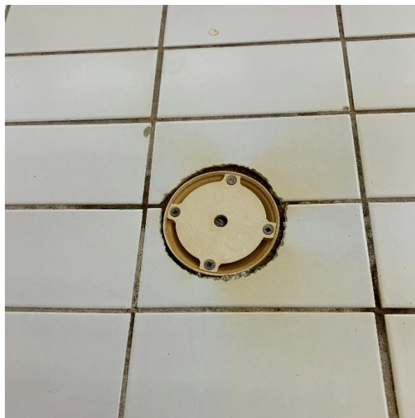
Figur 15: Manglende fuging rundt bunndyser
