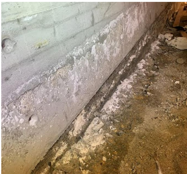
Figur 4: Avskalling betong/ utfelling nedre del mot terreng
