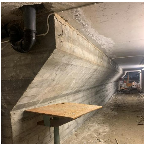
Figur 10: Fuktmerker/ avleiring i dekke
