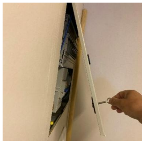
Figur 20: Utstyr i fordeling hindrer lukking
