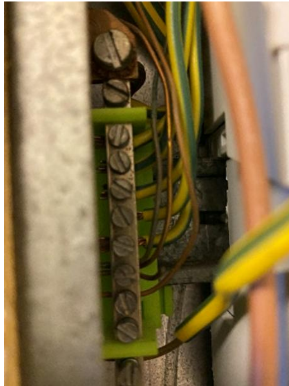
Figur 16: Tilkoblinger av kurskabler
