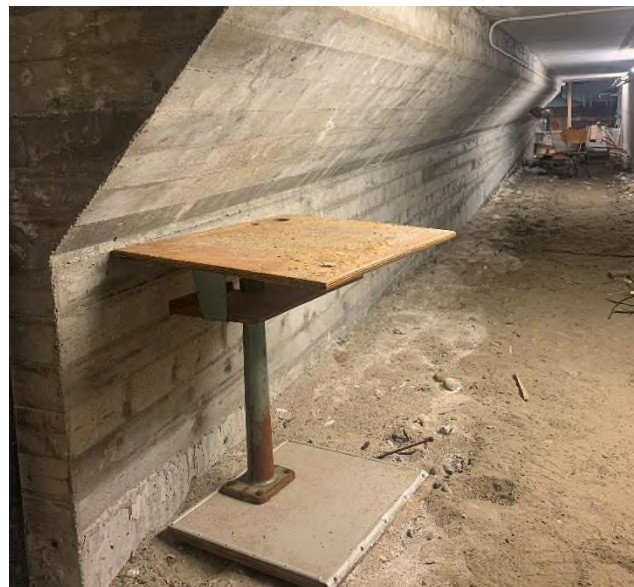
Figur 2: Manglende betonggulv på øst og nordsiden av bassenget i underetasjen
