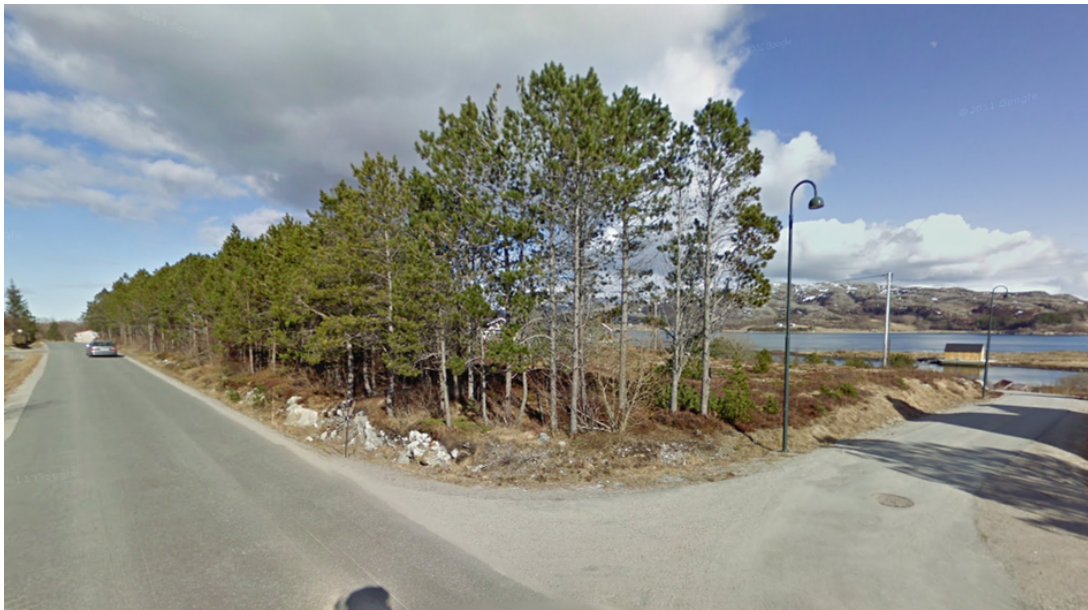
Eksisterende avkjørsel fra Engasvegen til Pettersholmsvegen – tilførselsveg til nye boligtomter langs Engasvegen.
