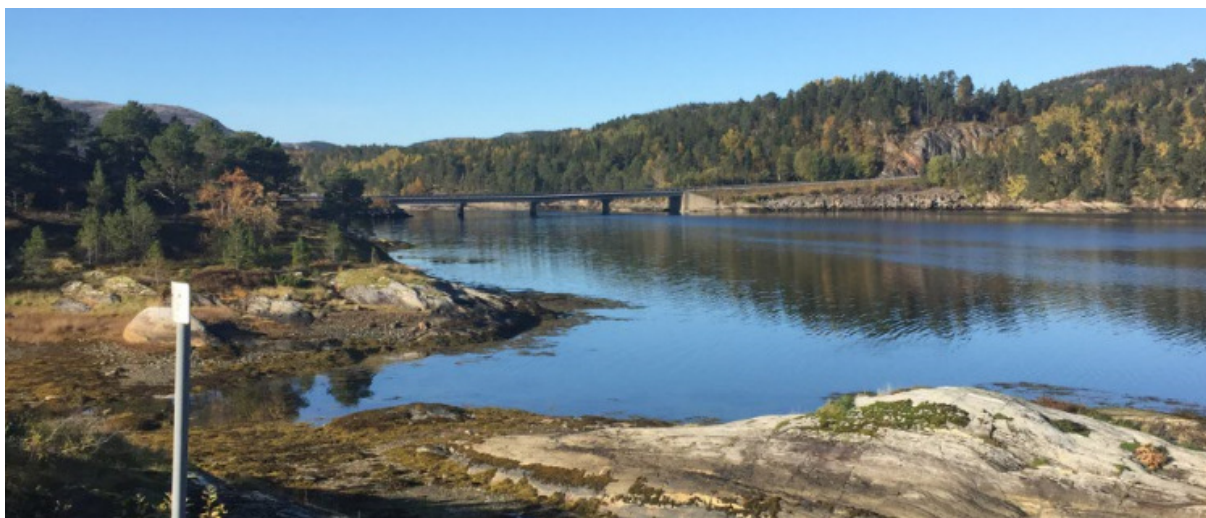
Figur 6. Simlestraumen bru sett fra øst. Bildet er tatt fra Fv17, før utfylling.
