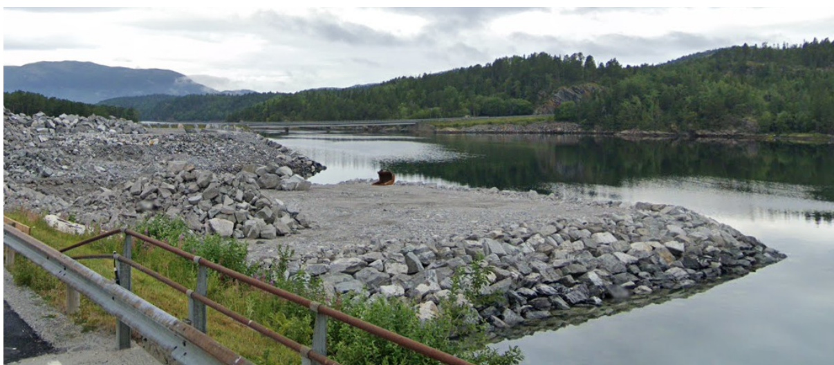
Figur 7. Simlestraumen bru sett fra øst. Bildet er tatt fra Fv17, under utfylling august 2019 (Google Maps).
