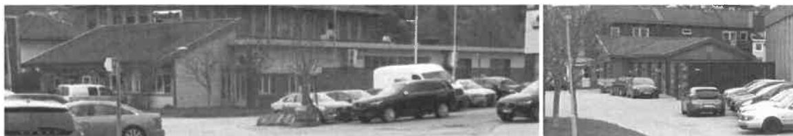
Figur 11. Bygninger som er planlagt revet.
