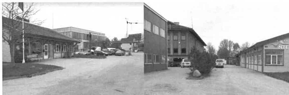
Figur 5. Eksisterende bygninger har svært liten enhetlig bygningsstruktur.
