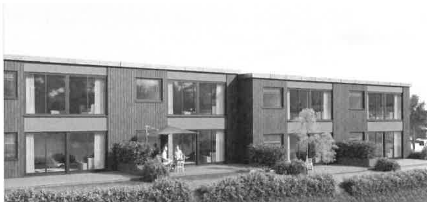
Figur 2: Fasade mot øst
