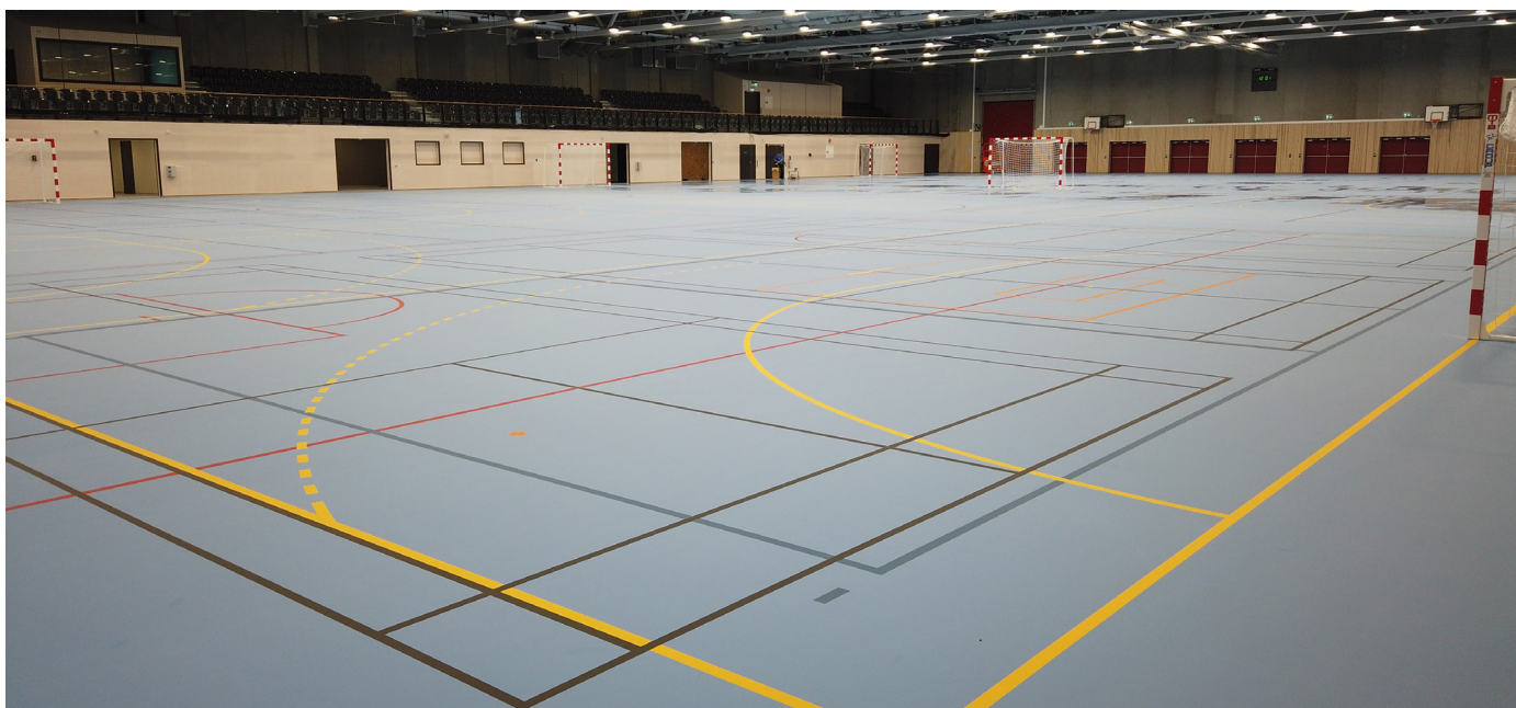
Hallflate SinkabergHansen Arena Rørvik
