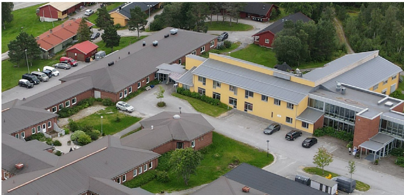
Sjøsiden har flyttet fra mursteinsbygget øverst til venstre til andre etasje på NBBS-bygget midt i bildet. Flyttingen er ikke lang, men forskjellen i standarden på byggene er likevel store.
