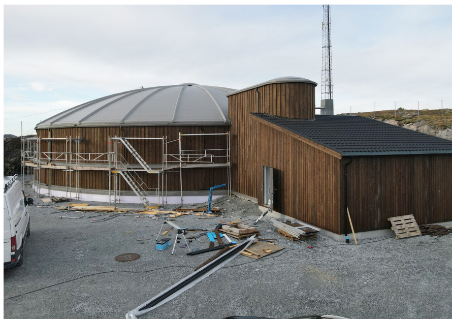
Nytt høydebasseng på Marøya ble ferdigstilt i 2022
