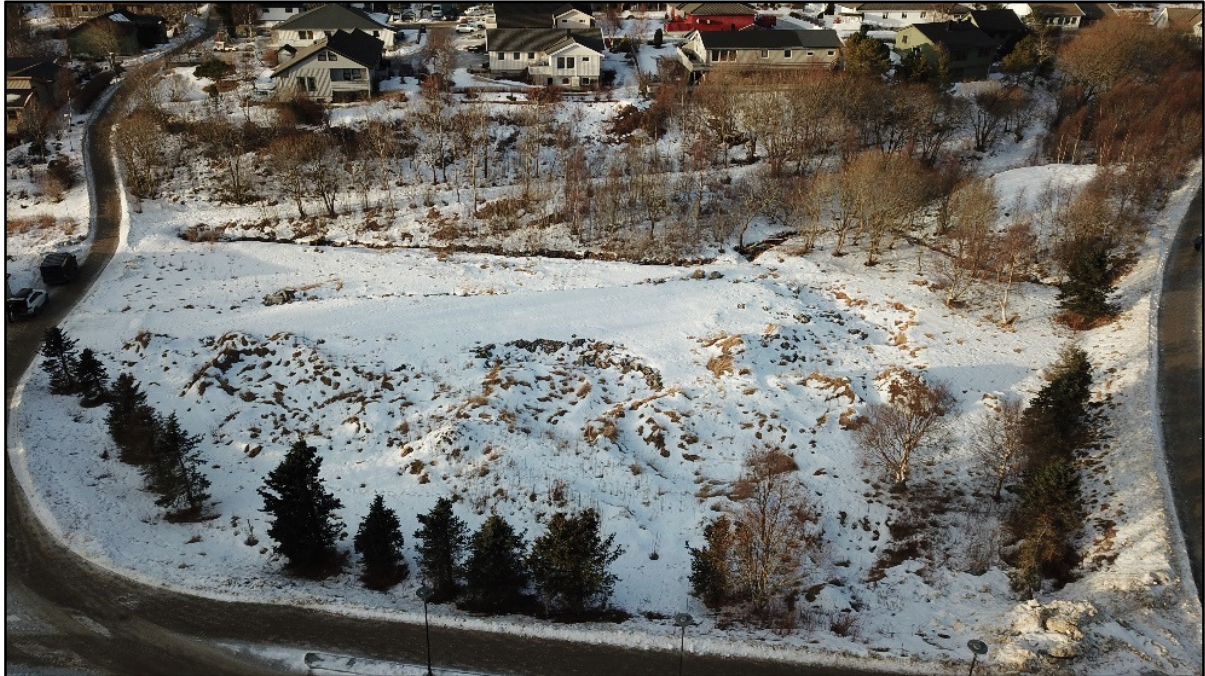
Dronebilde over viser byggeområdet sett fra eksisterende vegkryss i sørøst
