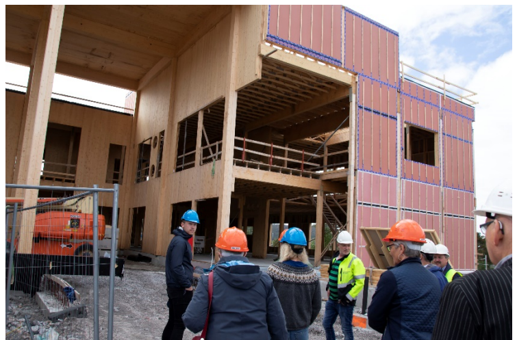
Formannskapets medlemmer var fornøyd med det de fikk se på byggeplassen og sa det var lettere å forstå omfanget av bygget når de har vært på befaring
