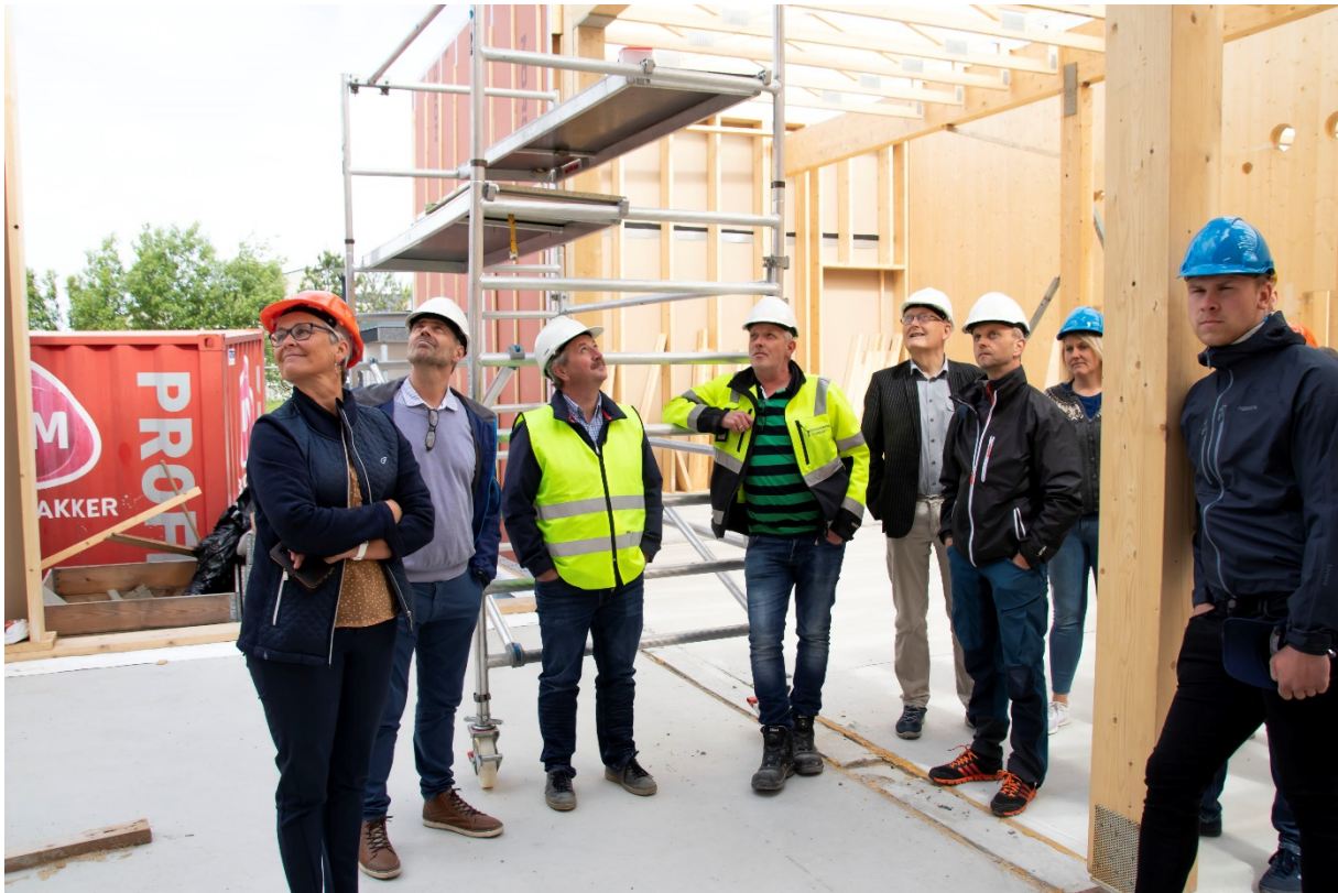
Kaj Jonny Årsandøy fra Entreprenør Einar Olsen AS viste formannskapsmedlemmene i Nærøy rundt på byggeplassen til nye Kolvereid barneskole og bibliotek.
