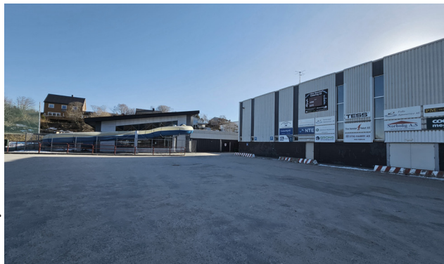
Vi avventer fortsatt takst på skadene i Rørvikhallen
