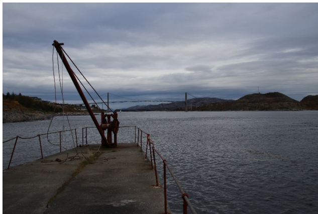
Ved naustet er det også en kai med en kran for å heise opp båter.
