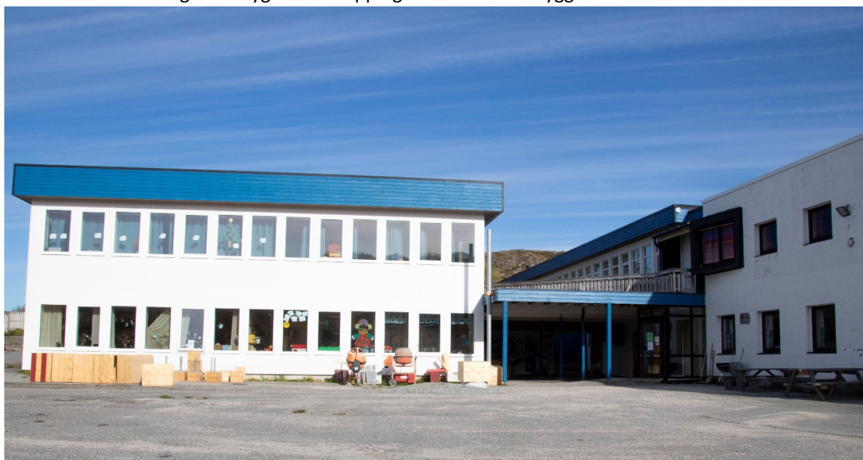
Skolen er bygd i etapper. Bygget til venstre er fra 80-tallet. Det en ser helt til høyre er bygd på 90-tallet, mens bygget i bakgrunnen er den eldste delen fra tidlig 70-tall. Blåfargen fikk skolen etter innsats fra foreldre og naboer for noen år tilbake
