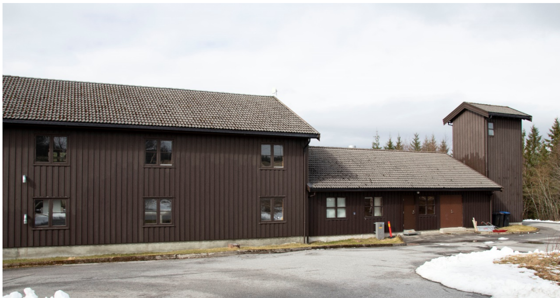
Det som i dag kalles Nærøy og Vikna fellesvassverk styres av kommunalteknisk i Nærøy. Her fra hovedbasen på Finne ved Kolvereid.
