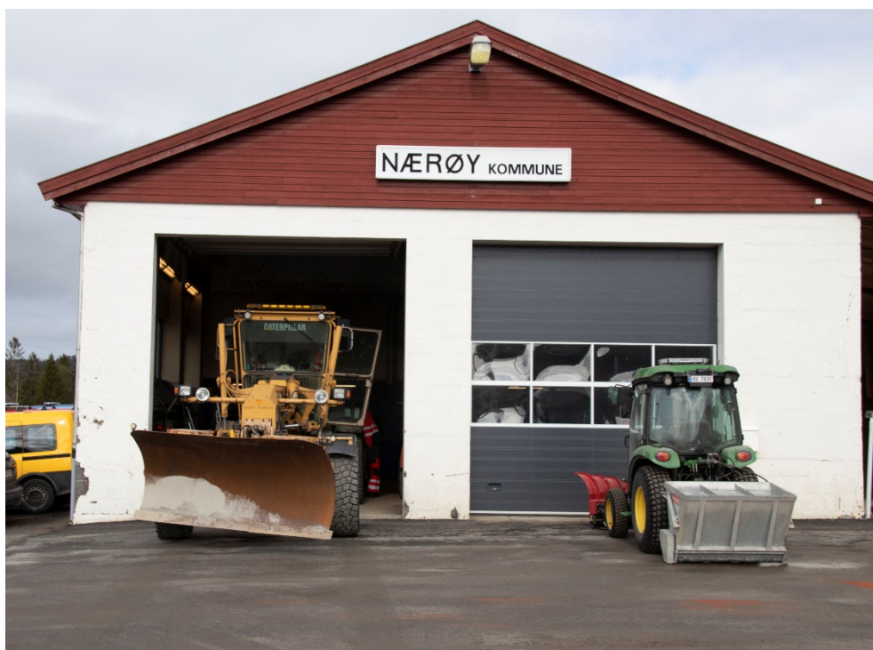
Kommunalteknisk har sitt hovedsete ved kommuneverkstedet på industriområdet på Kolvereid. Her har de hatt tilhold i over tretti år. Kommunen har etter hvert fått mye utstyr slik at de kan gjennomføre mye av vedlikeholdsarbeidet selv.
