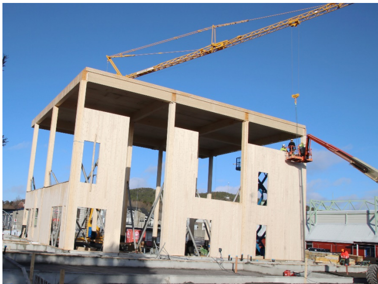
Denne uken kom de første veggene opp på bygget som skal huse biblioteket på Kolvereid.
